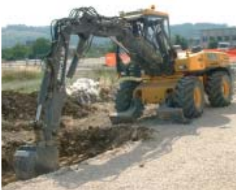
▼ Ausheben des Grabens vor dem Verlegen der Kanalisation
