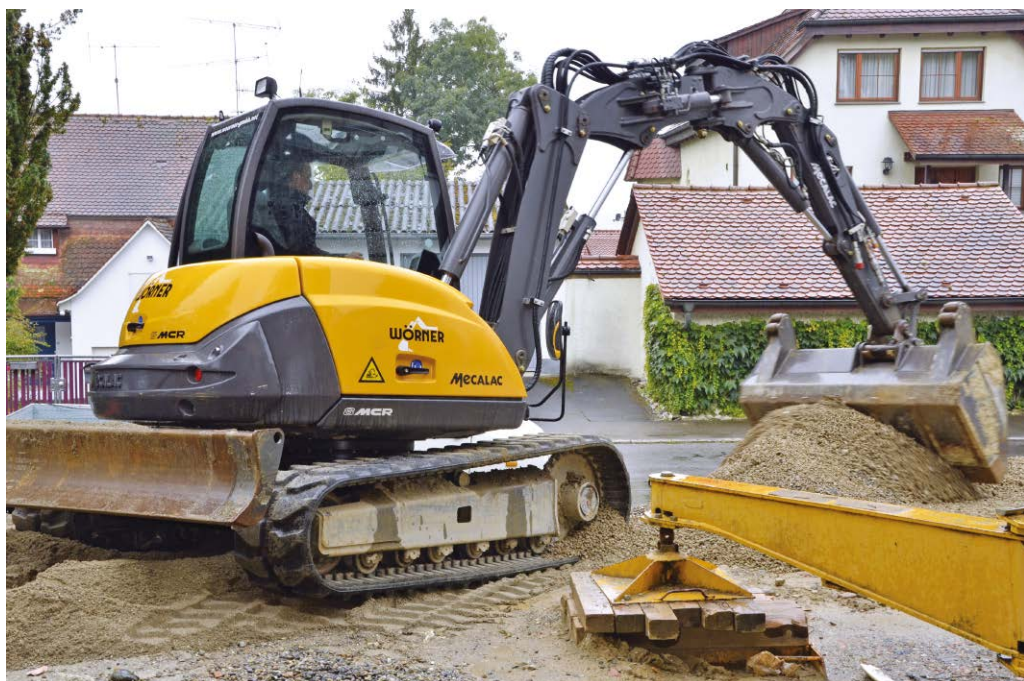
➔ Multifunktional: Der 8MCR ersetzt einen Radlader auf der Baustelle.
